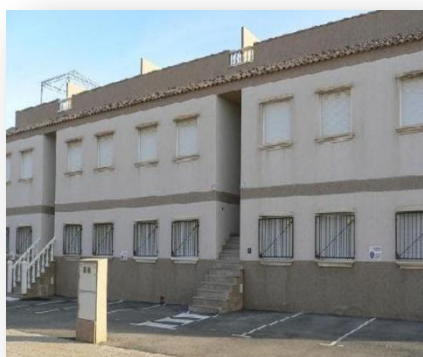
Residencial Torre Golf IV – Orihuela Costa
